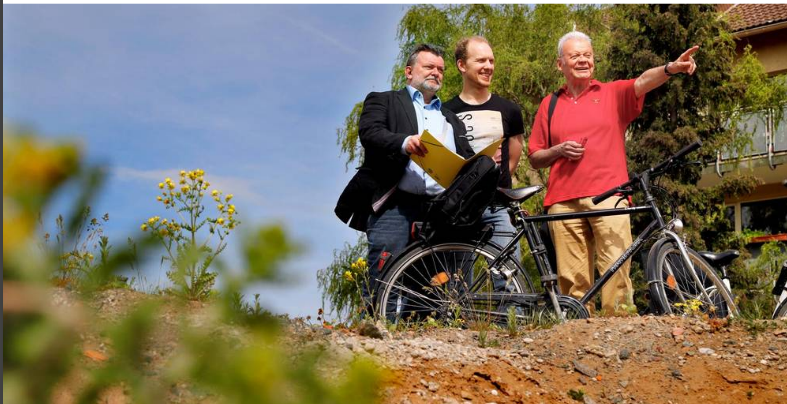
Alfred Hofmann (von links), Sven Amann und Jürgen Krapp an der ausgehobenen Baugrube ihres Projektes. Foto: Andreas Kelm
